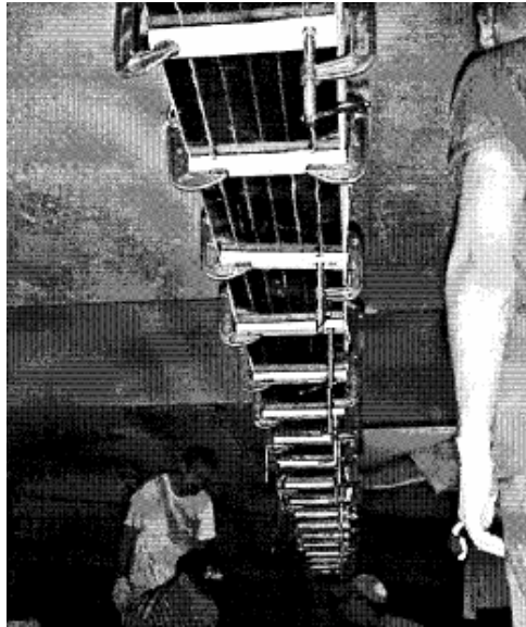
Figura 9-4 – Pultrusi di carbonio applicati usando morsetti removibili sul ponte I-704 in USA (Miller et al. 2001).
