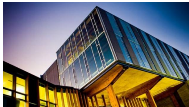
COLLEGE OF CREATIVE ARTS, MASSEY UNIVERSITY, WELLINGTON, NUOVA ZELANDA - EDIFICIO IN LEGNO LAMELLARE POST-TESO (TECNOLOGIA PRES-LAM), SISTEMA A BASSO DANNEGGIAMENTO PROGETTATO CON APPROCCIO AGLI SPOSTAMENTI
