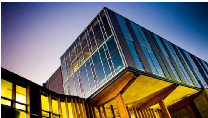
College Of Creative Arts, Massey University, Wellington, Nuova Zelanda - Edificio In Legno Lamellare Post-Teso (Tecnologia Pres-Lam), Sistema a Basso Danneggiamento progettato con Approccio agli Spostamenti
